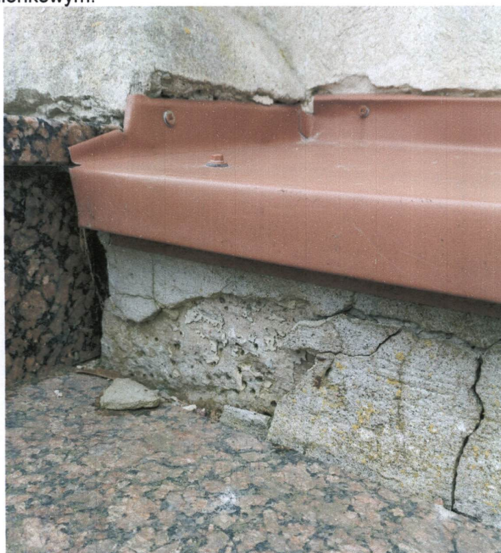
Zdj. 4 Widok cokołu z pozostałością tynku strukturalnego imitującego kamień naturalny
