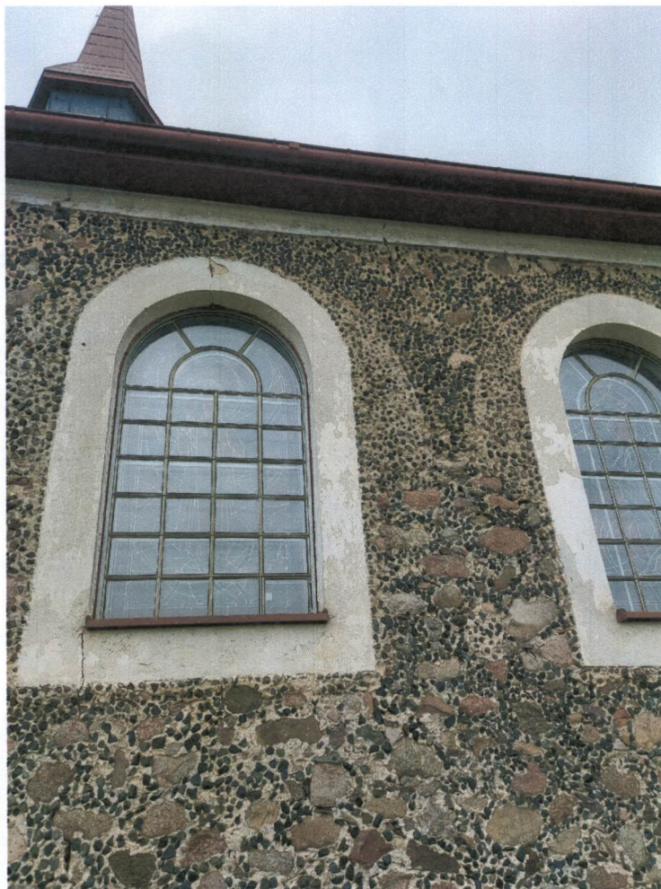
Zdj. 3. Widok fragmentów ścian nieotynkowanych wykończonych tynkiem strukturalnym, krzemionkowym.
